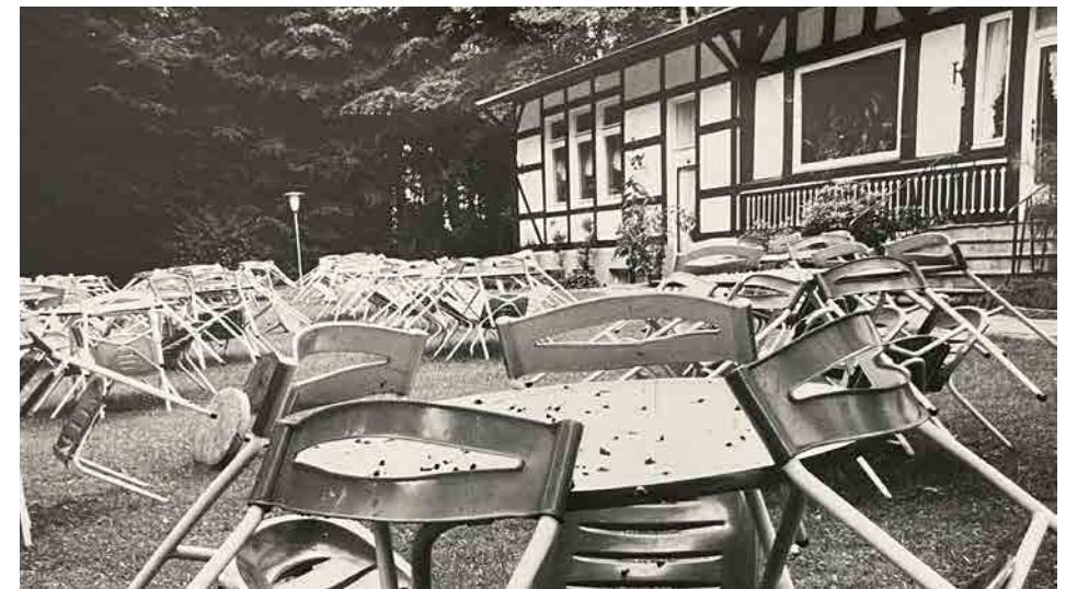
Erweitert 1977, Stand 1980 Bauakte Archiv der Stadt Soest
