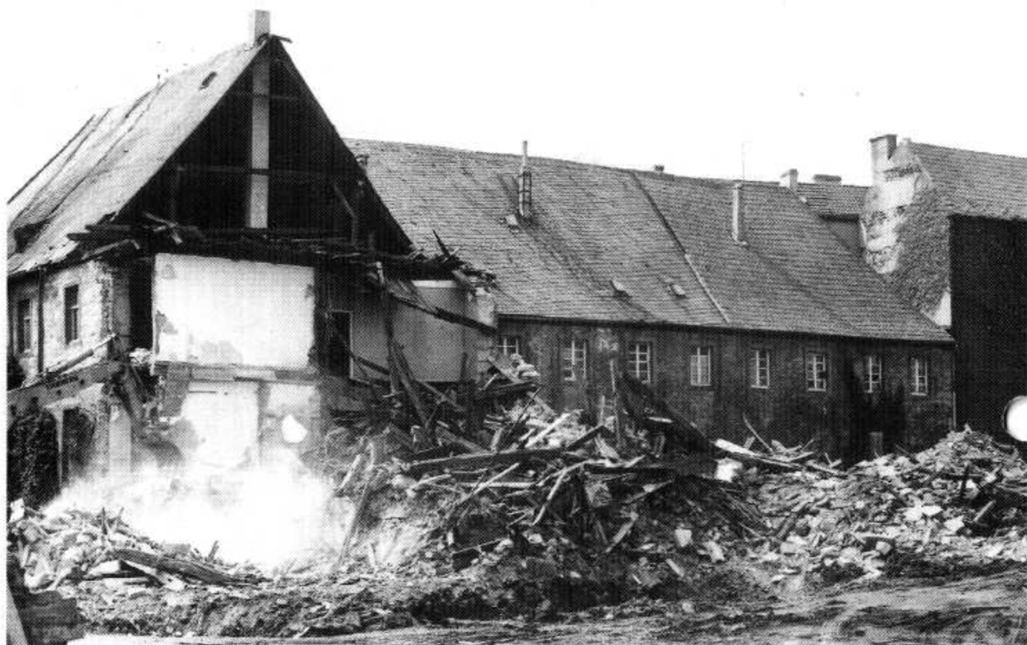
Der am 1. Juli 1975 im Soester Anzeiger veröffentlichte Artikel wurde mit diesem Foto illustriert: „Die Abräum- und Bodenaushub-Arbeiten am ehemaligen Dominikaner-Kloster eröffnen in diesen Tagen die Bautätigkeit für das Kaufhofgelände.“ Foto: Soester Anzeiger im Stadtarchiv, Neg.-Nr. A 4187/35a
